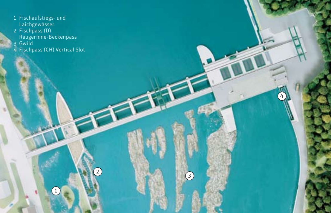
Das Umgebungsgewässer und zwei Fischtreppen machen das Wasserkraftwerk für Fische passierbar.
