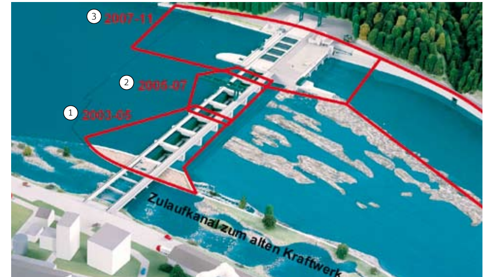
Neue Kraftwerksanlage mit Darstellung der Baugruben 1. Bau Stauwehfelder 7–5 und Wehrinsel (2003–2005) 2. Bau Stauwehfelder 4–2 (2005–2007) 3. Bau Maschinenhaus und Stauwehfeld 1 (Inbetriebnahme 2010) sowie Rheineintiefung
