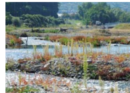
Am Wasserkraftwerk Rheinfelden entsteht ein naturnahes Fischaufstiegs- und Laichgewässer.
