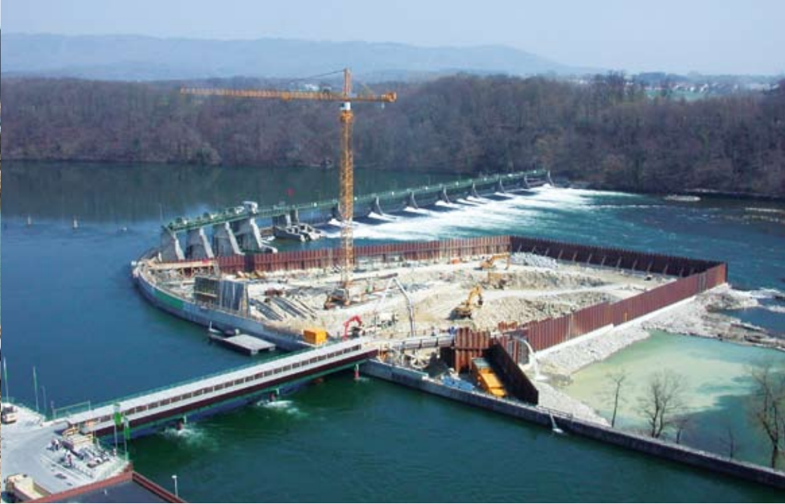
Erste Baugrube für das Stauwehr, März 2004
