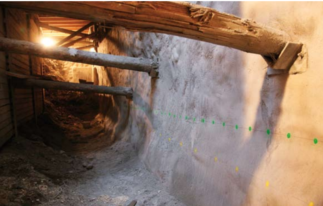
Beim Schloss sanierten Handwerker die Fundamente im Außenbereich des Schlosses.
