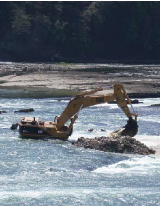
Erste Aushubarbeiten im August 2003
