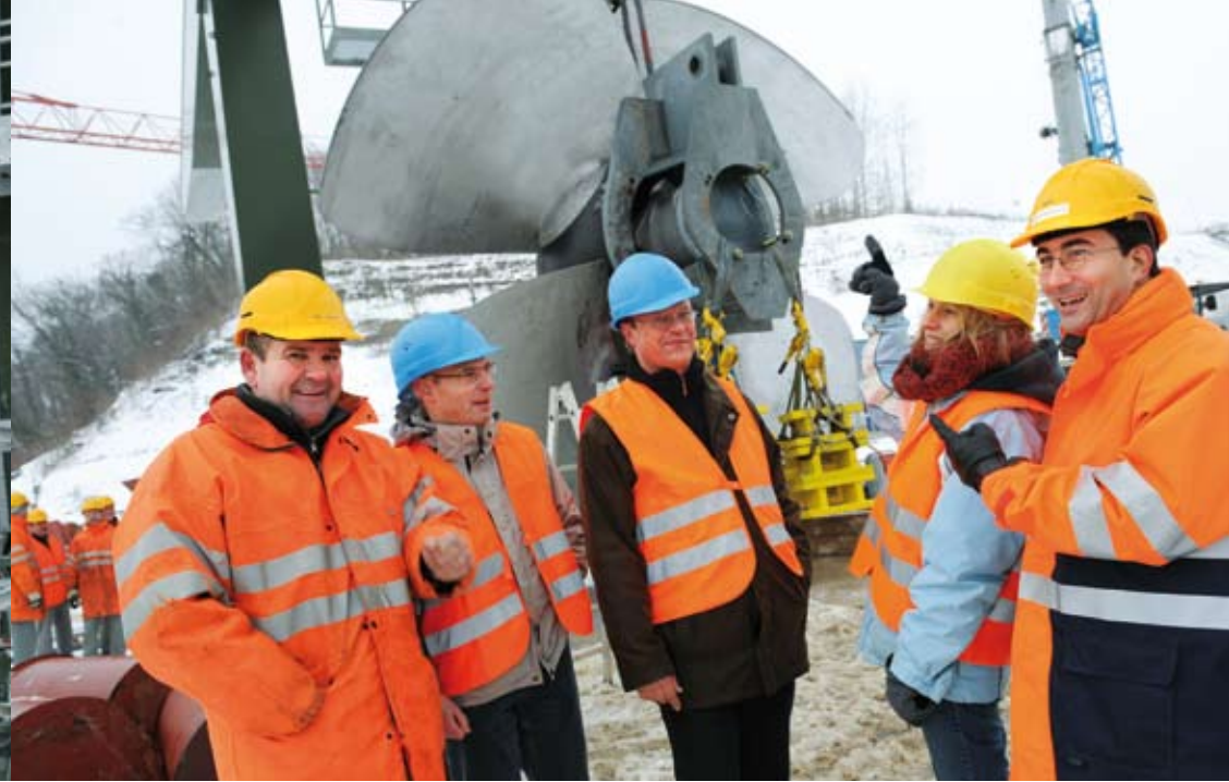
Einheben Laufrad, Januar 2010
