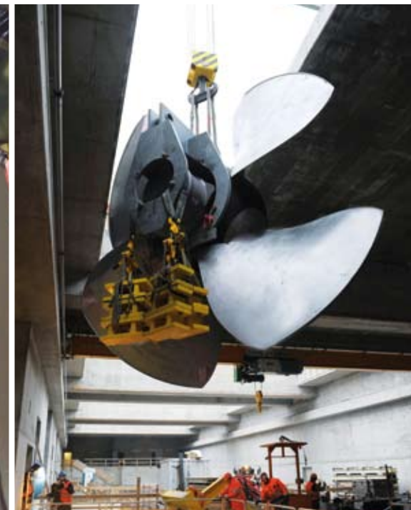
Einheben Laufrad, Januar 2010
