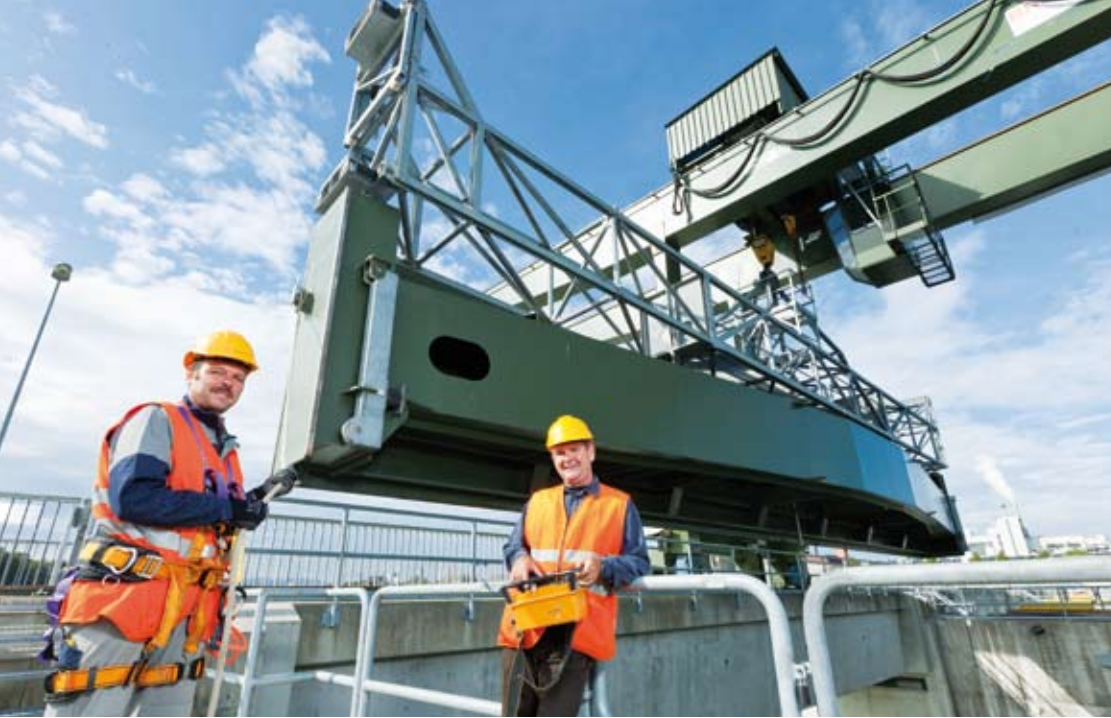
Christian Retz (rechts) versetzt eine Dammtafel, links: Rainer Kessler.
