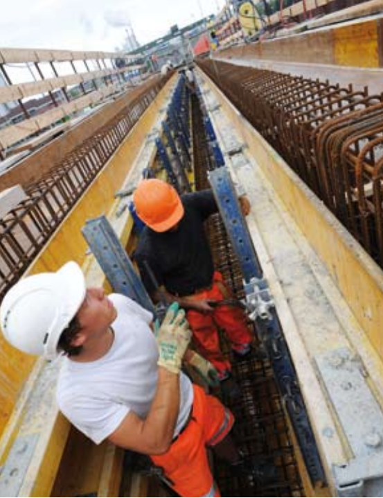
Bau Kranbahnbrücke, Mai 2009
