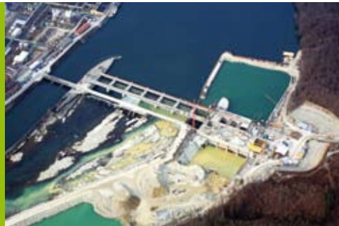
2010 – Baugrube nach Flutung
