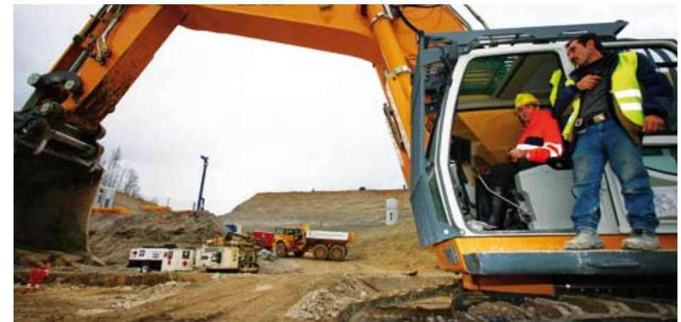
Martin Steiger, Vorsitzender der Geschäftsleitung der Energiedienst Holding AG, beim Spatenstich für das Maschinenhaus im Januar 2007
