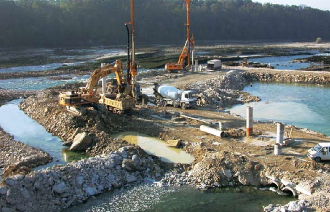
Arbeiten für die Baugrubenumschließung, September 2003
