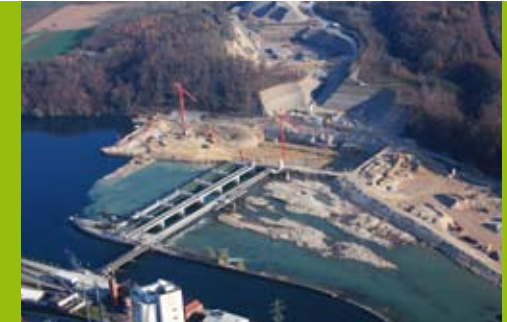
2007 – Aushub Baugrube Maschinenhaus
