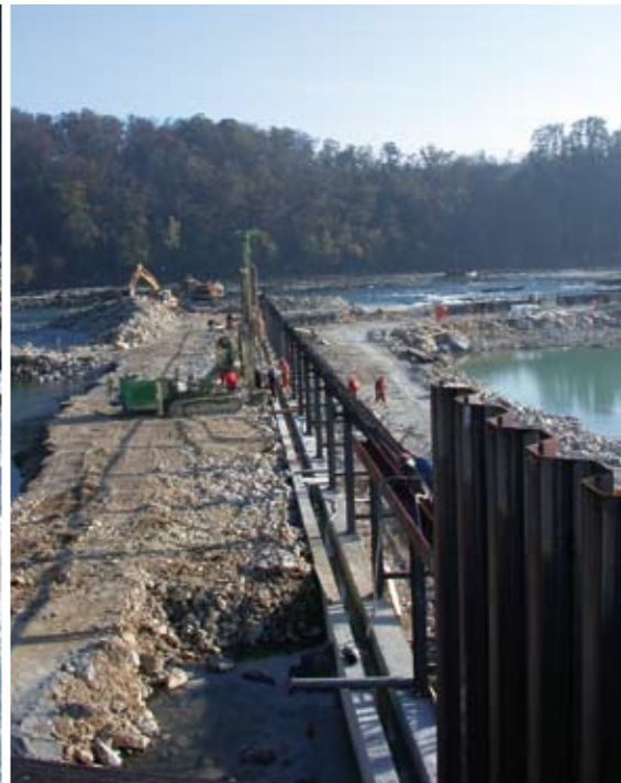
Setzen der Spundwand für die Baugrubenumschließung, Oktober 2003
