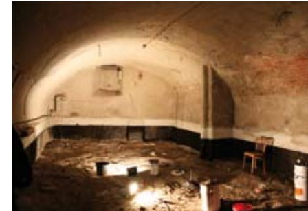
In den Gebäuden wurden die Keller abgedichtet.
