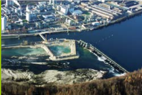
2003 – Erste Baugrube Stauwehr
