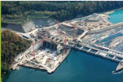
2010 – Baugrube vor Flutung
