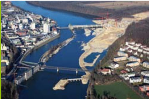
2008 – Rheineintiefung bis Steg
