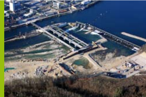
2007 – Erstellung Baugrube Maschinenhaus
