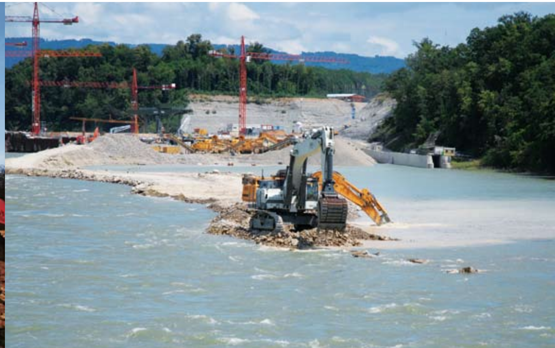
Erstellen des Schüttdamms, Juli 2009
