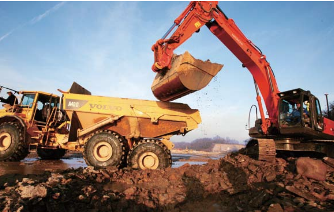
Im Dreiminutentakt wurde der Aushub abgeführt.
