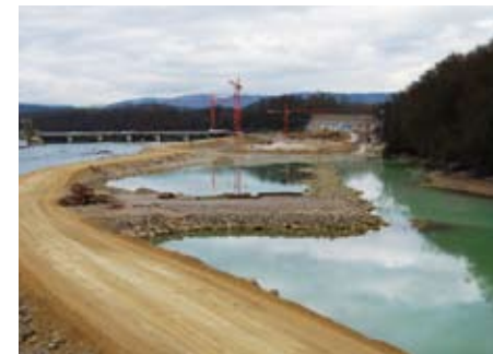
Damm für den Abtransport des Aushubmaterials
