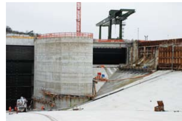
Die Maschinenhaus-Baugrube im März 2010: Für eine optimale Anströmung sorgt der Trennpfeiler.
