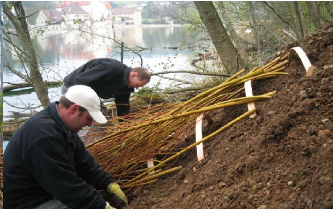
Energiedienst-Mitarbeiter legen einen Zugang vom Wasser zur Biberburg an.
