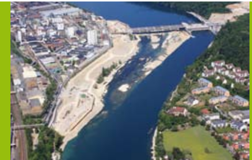
2011 – Bau Fischaufstiegs- und Laichgewässer
