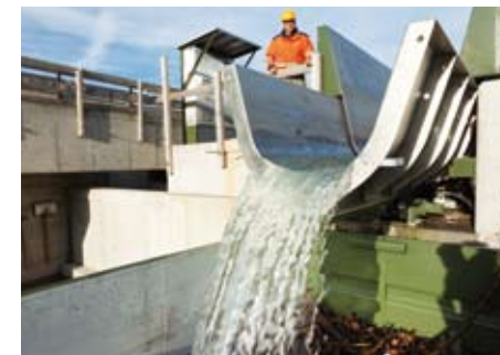
Die Rechenreinigung befördert jährlich viele Tonnen Geschwemmsel aus dem Rhein.
