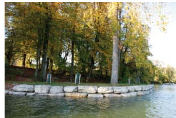
Die Uferbefestigung wurde dem neuen Wasserstand angepasst.
