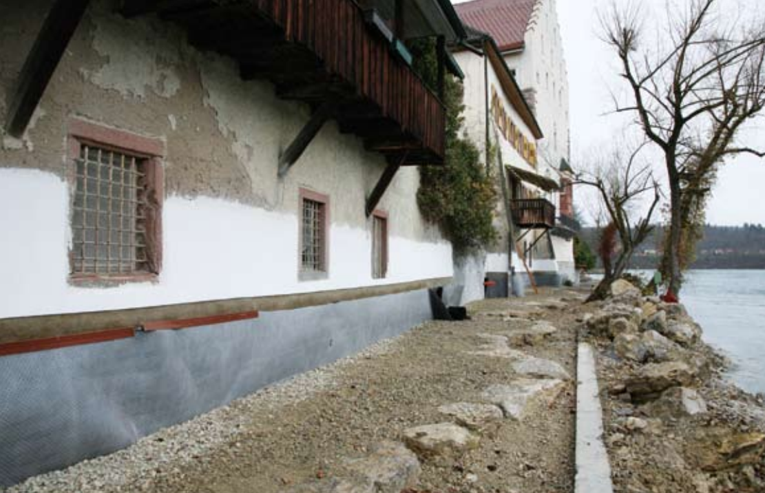
Eine Aufschüttung sichert das Rheinufer an den Gebäuden.
