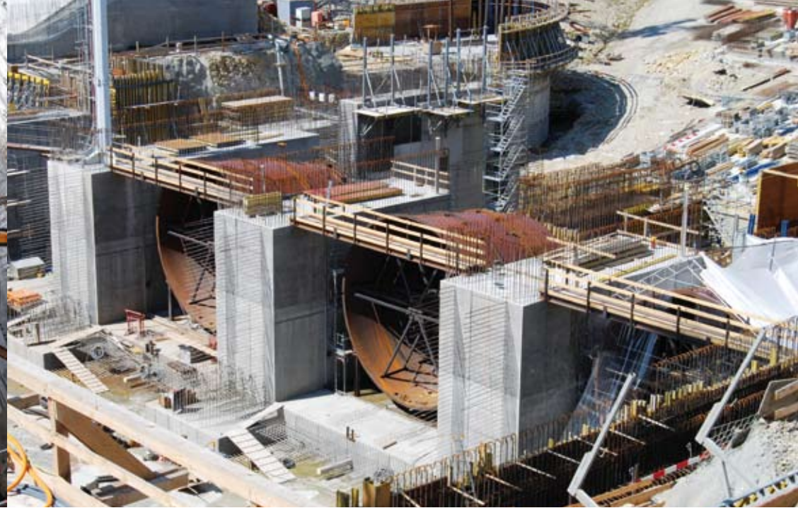
Betonarbeiten Saugrohre, August 2008
