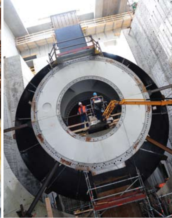
Arbeiten am Stützringschacht, Mai 2009
