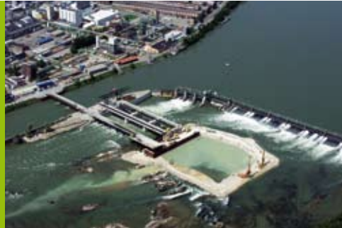
2005 – Zweite Baugrube Stauwehr
